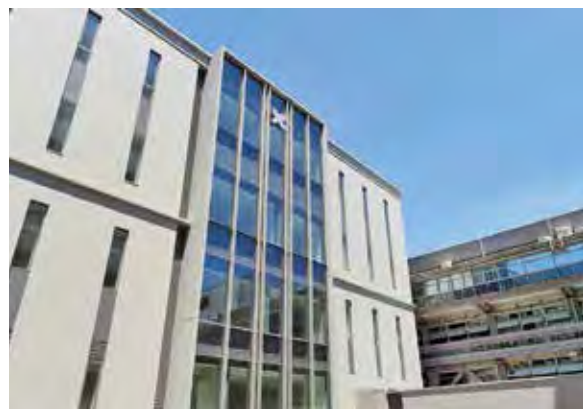
2018年4月に竣工した大病院1号館のある信濃町キャンパス
